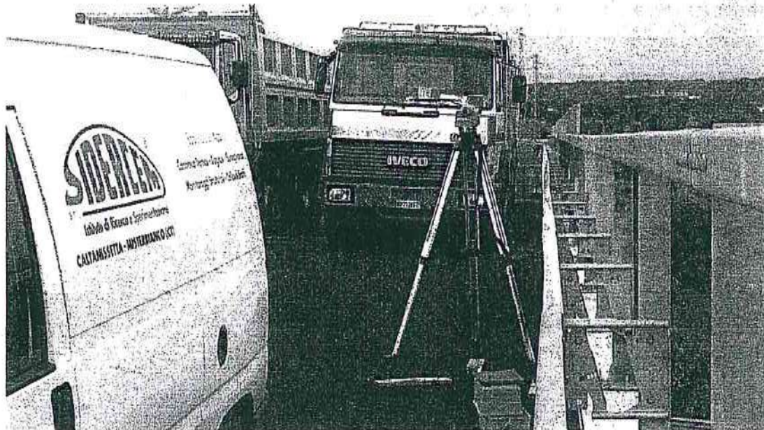
FOTO 6: Prova 3 – Carico massimo
